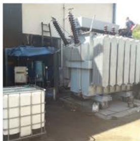
Mašina za obradu ulja kapaciteta 3000 l/h
